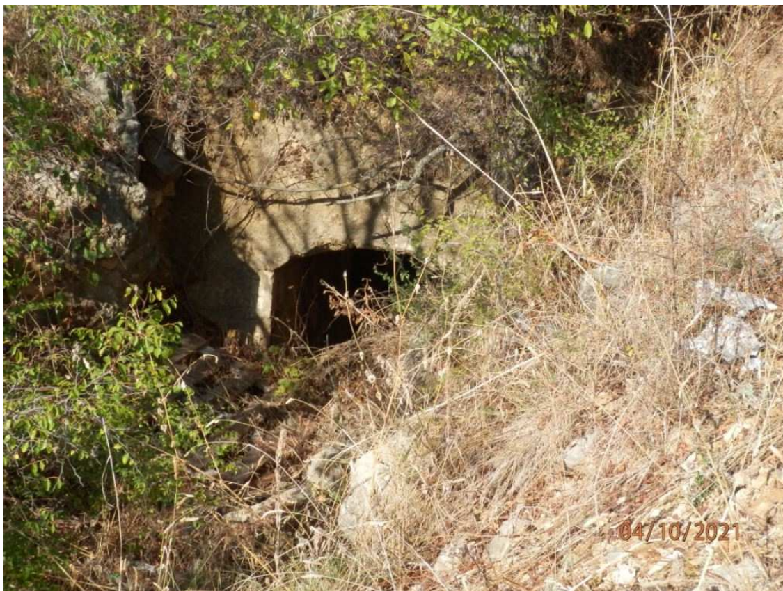
Slika 8. Jedan od ulaza u bunkere
