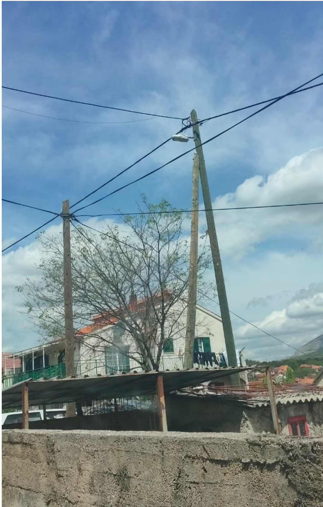
Slika 13. Pogled na stup u naselju kao predloženim mjestom instalacije opreme
