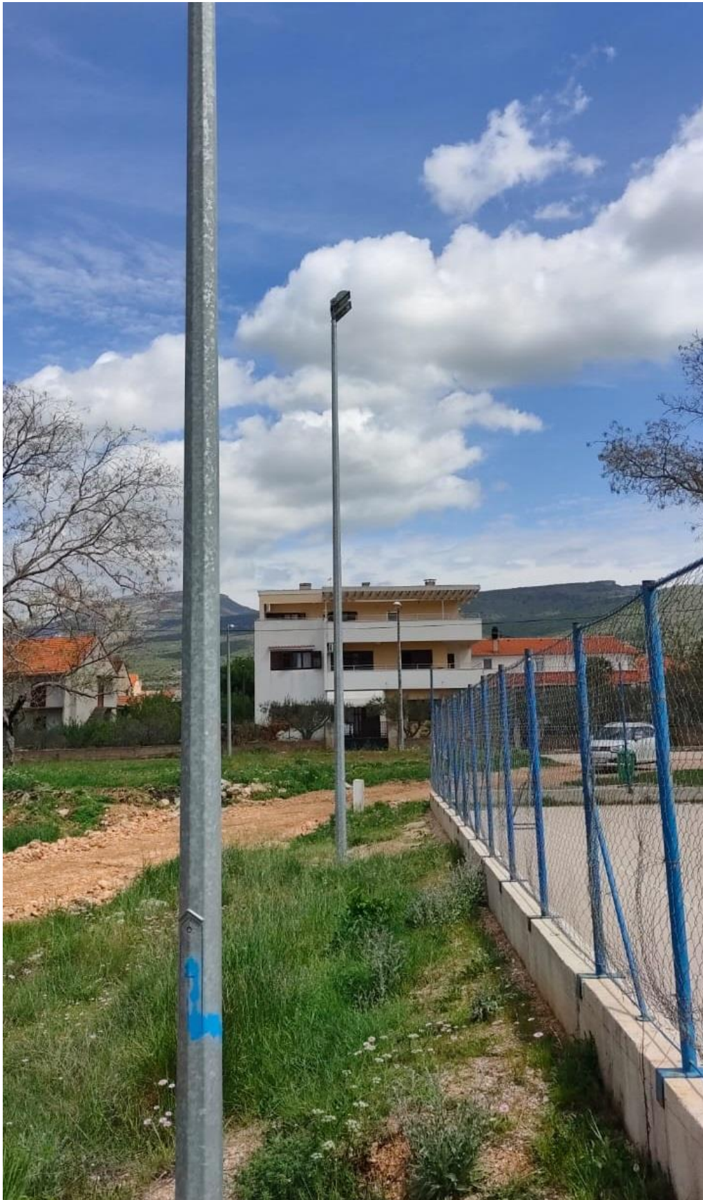
Slika 18. Pogled na stup pored zgrade branitelja kao predloženim mjestom instalacije opreme
