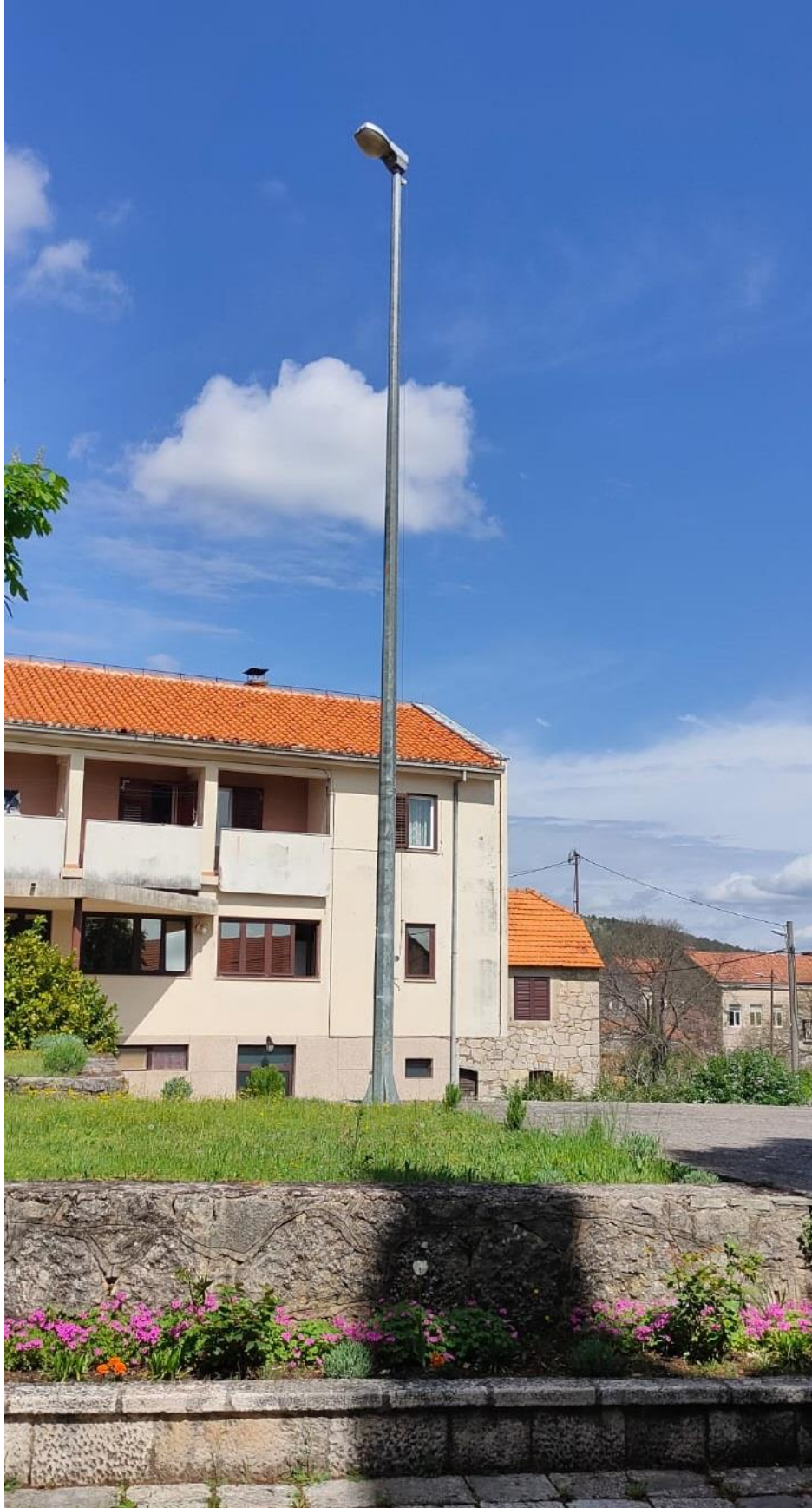
Slika 5. Pogled na stup uz župni ured kao predloženim mjestom instalacije opreme
