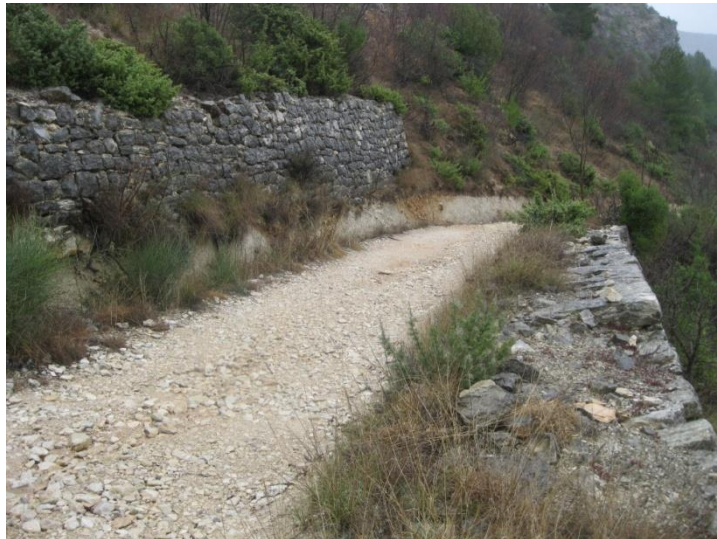
Potporni zid desno bez završetaka, a obložni zid lijevo s podlokanim temeljem
