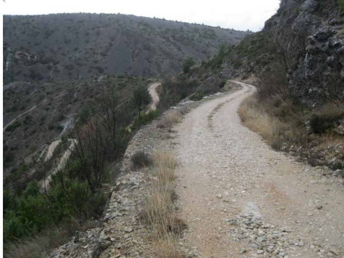
Potporni kameni zid bez završetaka (krune zida) lijevo i zatrpan odvodni kanal desno
