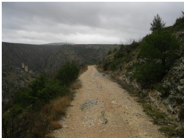
Voda ogolila stjenovitu podlogu, jer je odvodni kanal zatrpan nanosom i odronima
