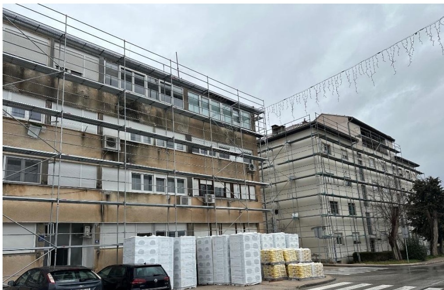
Slika 7.1-1. Energetska obnova dvije zgrade u ulici 142. brigade
